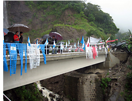
Inauguration of the Aldea Las Barancas Bridge
