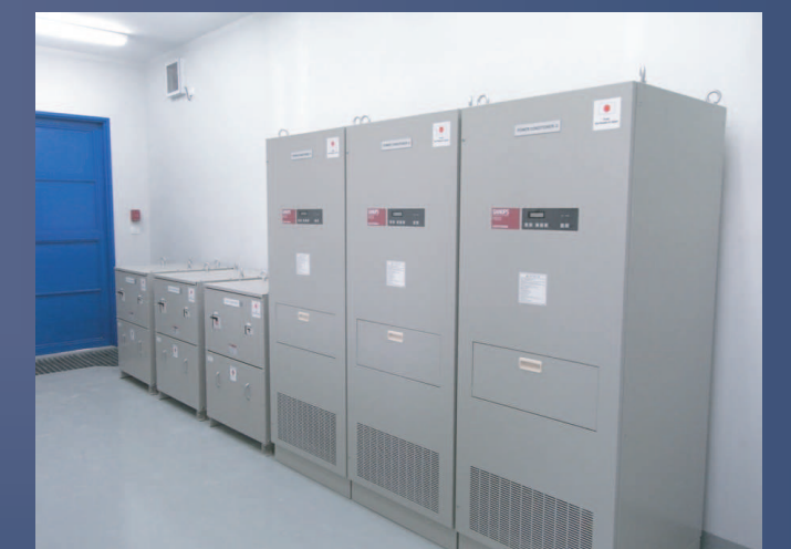
جهاز تحويل وتهيئة الطاقة غرفة الحارس Power Conditioner
