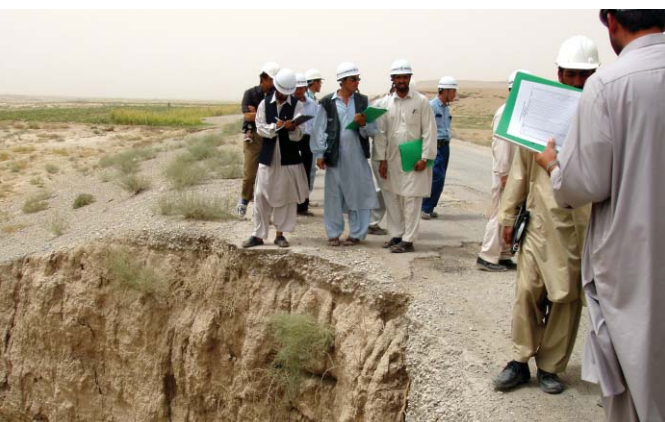
道路建設予定地を視察する工事関係者
