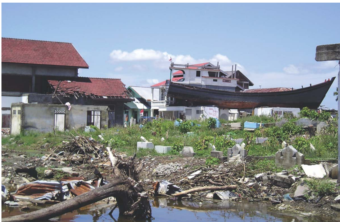
津波によって民家の上に打ち上げられた漁船（インドネシア）
