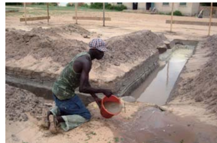
セネガルの学校建設工事
