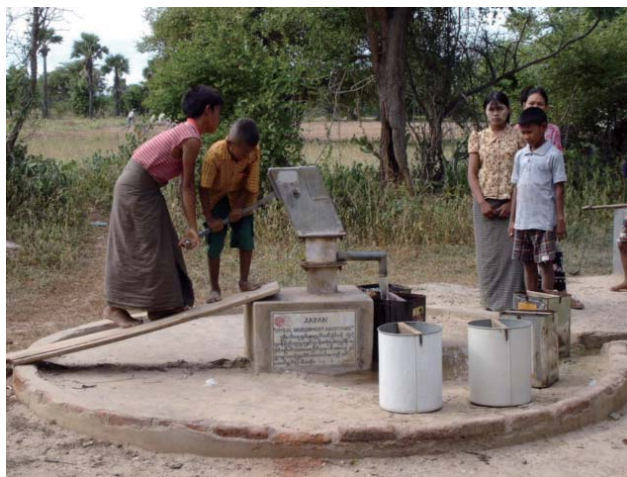
ミャンマーのプロジェクトで建設された井戸
