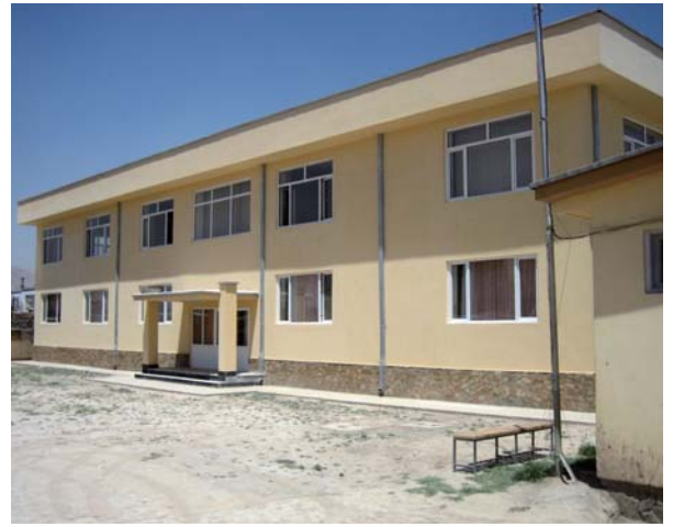
建設されたダシュテバルチ病院の研修施設
