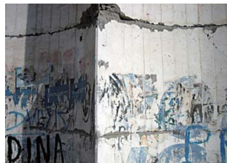
亀裂が入った給水塔。倒壊の危険があるため、別の場所に新設される
