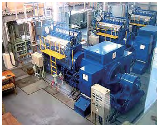
供与された軽油が使用されているツバルの発電所
