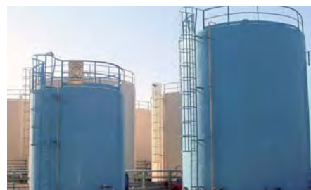
サマーワ大型発電所のタンク
