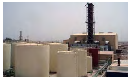
サマーワ大型発電所
