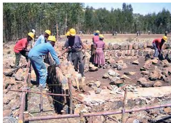
エチオピア・学校建設の基礎工事
