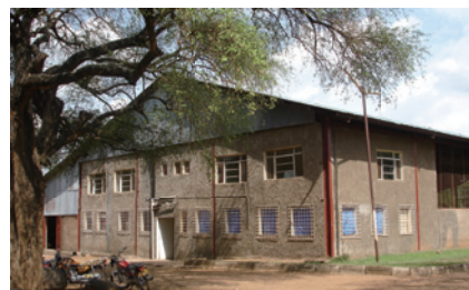
ジュバ職業訓練センターの外観
