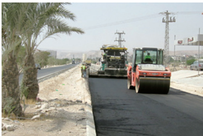
紛争予防・平和構築無償：施工中のAl Quds Street (アル・クワッツ道路) (パレスチナ)
