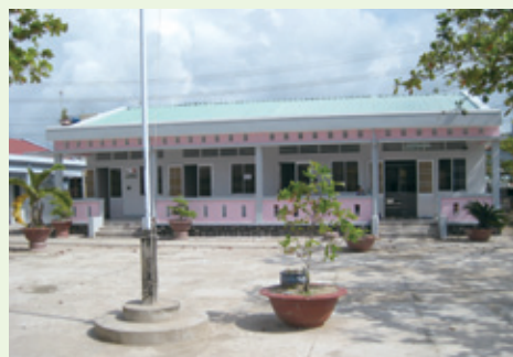
完成した保健センター(ベトナム)
