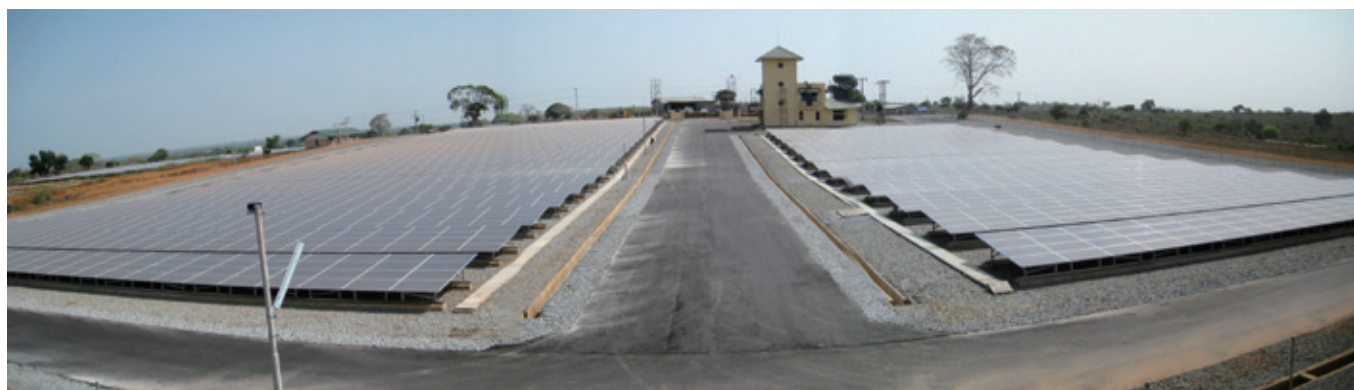
整然と並んだ太陽光パネル(完工前)
