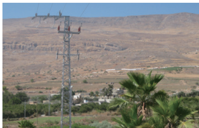
完成した送電線と鉄塔
