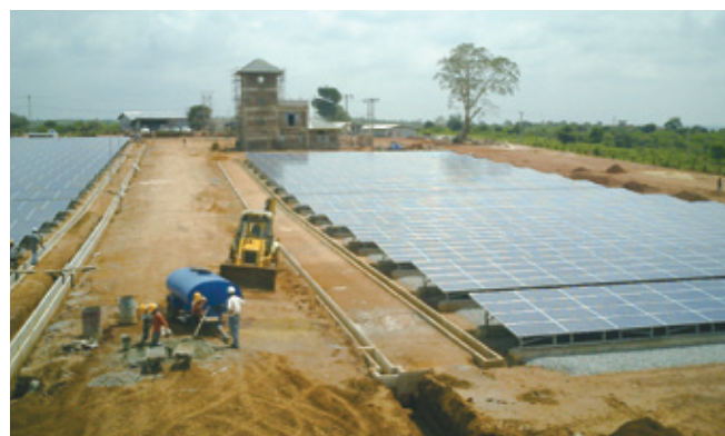
太陽光パネルの設置と敷地の整備が進む
