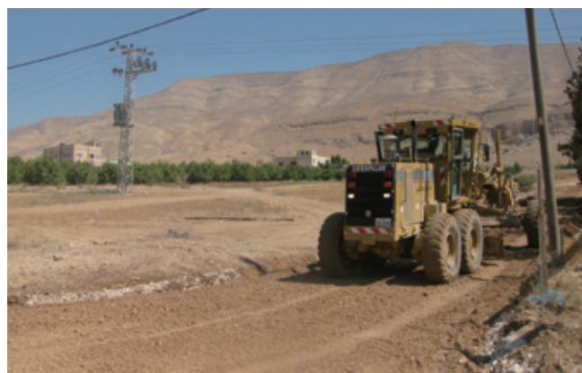
道路の補修工事(手前)と完成した送電線(後方)
