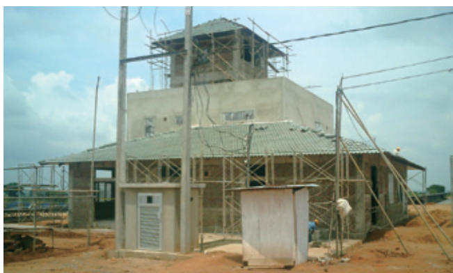
完成間近の管理棟
