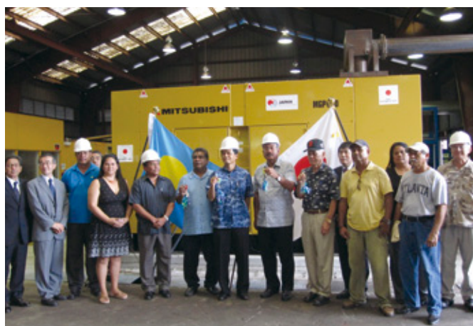
2011年11月に起きた発電所の火災による電力不足に対して、緊急無償により調達された発電機（パラオ）
