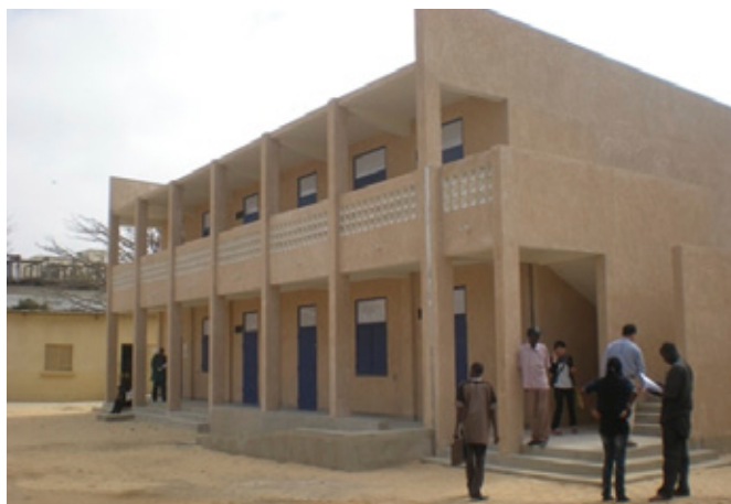
教室不足を改善するため、コミュニティ開発支援無償で建設したすべての建物に、車椅子通学に配慮したアクセススロープを設置（セネガル）
