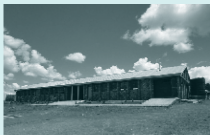
中等学校の理数科教育拡充のため建設された、 管理・理科実験棟 (レソト)
