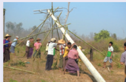
村民たちの全面協力で電柱を設置
