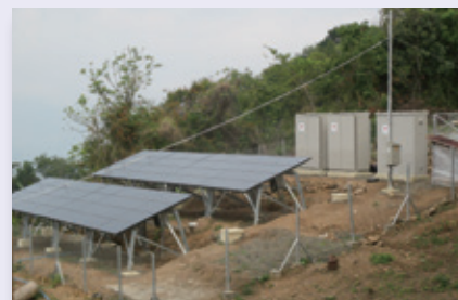
ソーラーパネルと発電機
