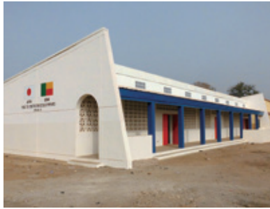
竣工した教室
