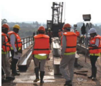
調達事後監査：ウガンダにおける監査対象プロジェクトの建設現場
