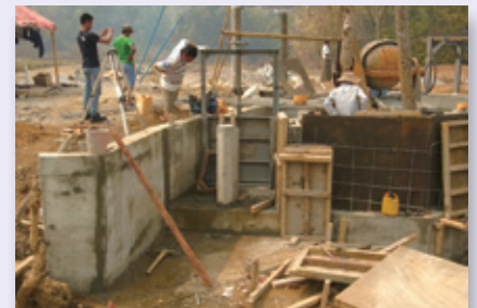
小水力発電の土木工事
