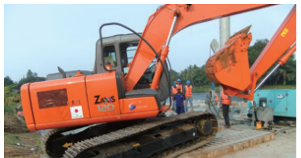
洪水対策で河川の浚渫を行うエクスカベーターを調達（インドネシア）
