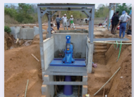
小水力発電ユニットが設置され試験中
