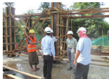
再建現場で工事指導を行う
