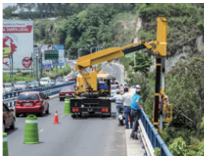
グアテマラで活躍している橋梁点検車
