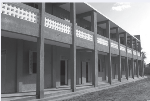
ニジェール「中学校教室建設計画」で完成した校舎
