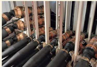
ケーブル敷設船の光海中継器保管庫
