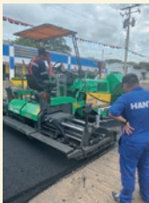
②アスファルトフィニッシャー
