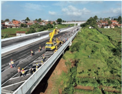
インドネシア 橋梁点検車トレーニング
