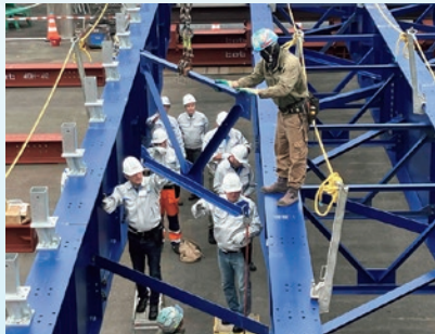
ウクライナ 運輸交通フェーズ2 応急組み立て橋トレーニング
