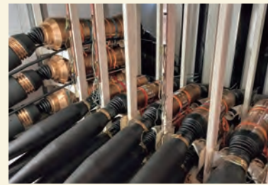
ケーブル敷設船の光海底中継器 保管庫
