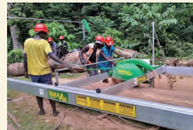
コミュニティでの簡易製材機の使用風景
