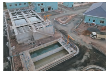
カンボジア コンポントム上下水道拡張計画
