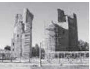
修復中のシャフリサーブス遺跡
