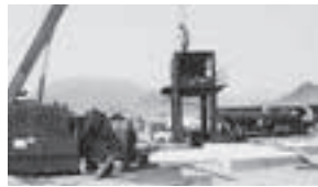
採石プラントおよびアスファルトプラントの設置予定地では、すでにプラントの組み立てが開始されています
