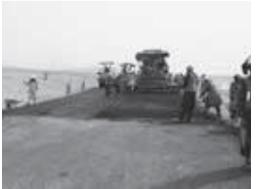
第二プロジェクト（本格的な舗装工事）が現在進行中のカンダハル・カブール間幹線道路。アスファルト塗装は三層にわたって行われる予定です（下記「カブール事務所便り」も併せてご覧ください）
