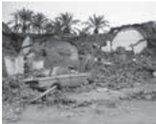
地震で倒壊した家屋（2004年1月、イラン・バム市での現地調査にて）
