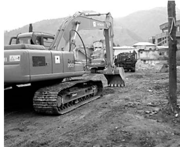
倒壊したAJK大学の瓦礫撤去作業に使用されている建設機械。国道修復などさまざまな復興の現場で活用される
