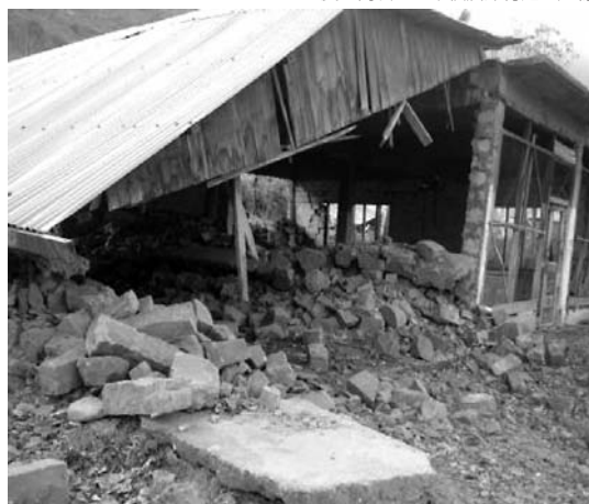
地震で倒壊した集積倉庫付近の建物
