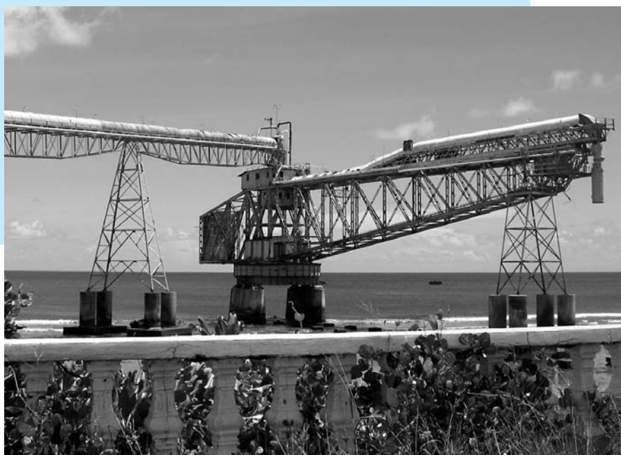
ナウルの軽油荷卸設備
