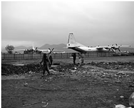
カブール国際空港ターミナルの新駐車場予定地
