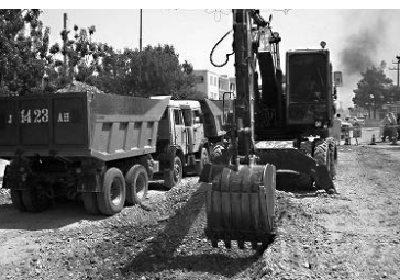
マザリシャリフの道路掘削作業
