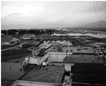
カブール国際空港管制塔からプロジェクトサイトを望む
