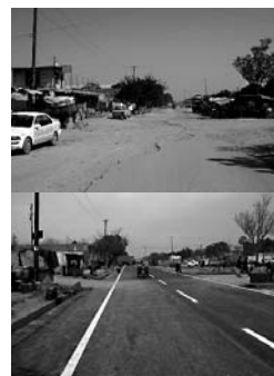
マザリシャリフ市内道路の改修前と改修後
