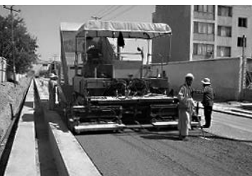
マザリシャリフの道路舗装作業
