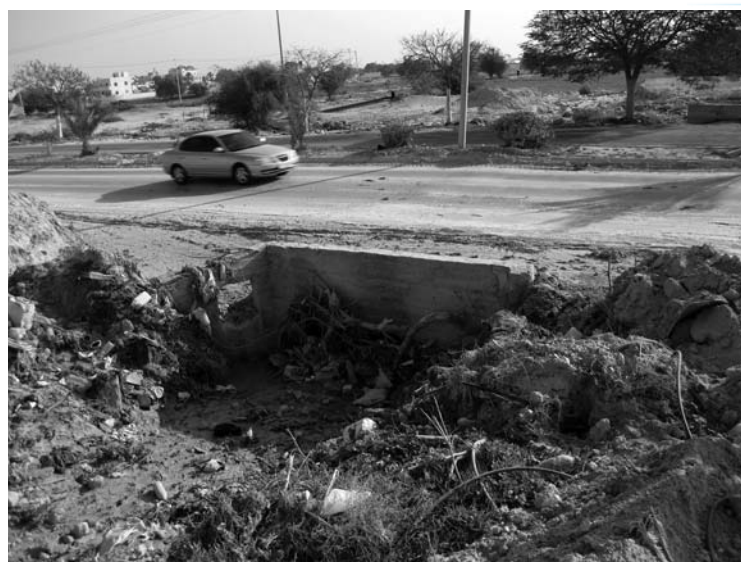
エルサレムとジェリコをつなぐ主要道路にある改修予定の排水カルバート(暗渠)いずれも土砂やゴミで埋もれているため、道路が冠水して通行不能になる
