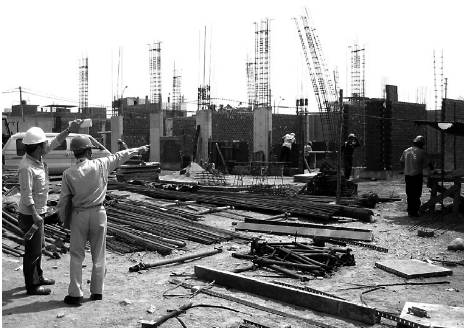
ペルー・イカ州地震への防災・災害復興支援で再建が進む学校の校舎
