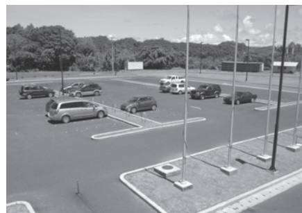
▲ 空港の駐車場に太陽光パネルを設置予定（パラオ）
