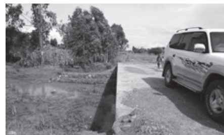
▲ 本案件で建設されたカルバート
