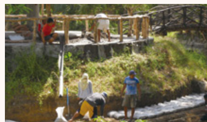
▲ 護岸の浸食を防ぐため「土のう」で補強をしている様子
