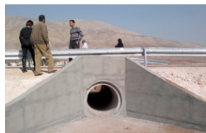
▲ 建設されたパイプカルバート（道路下を横切る水路）
