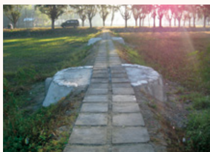
▲ 雨季に水浸しで通行不可だった場所に、「土のう」を積み上げてできた盛土構造の歩道
