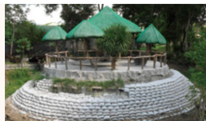
▲ 雨季に雨水がたまり浸食が進む護岸を「土のう」で補強
