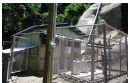
▲ セアシルに建設された約30m 2 の発電所
