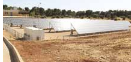
▲ 280kWの太陽光パネル
