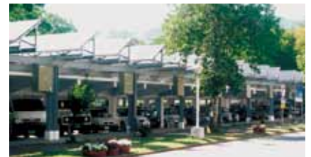
▲ パキスタン国内で初となる系統連系型太陽光発電システム
