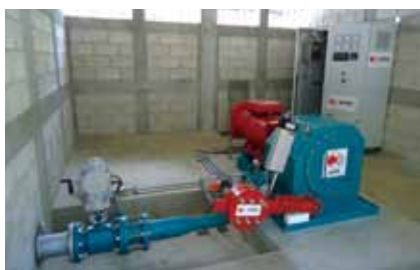
▲ 水車発電機とコントロールパネル(右奥)
