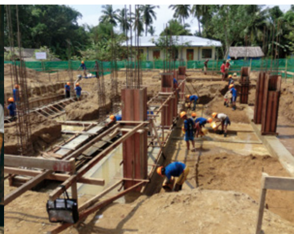
▲ サイクロン「ナルギス」被災地小学校兼サイクロンシェルター建設計画。Shwe Gone小学校での施工の様子
