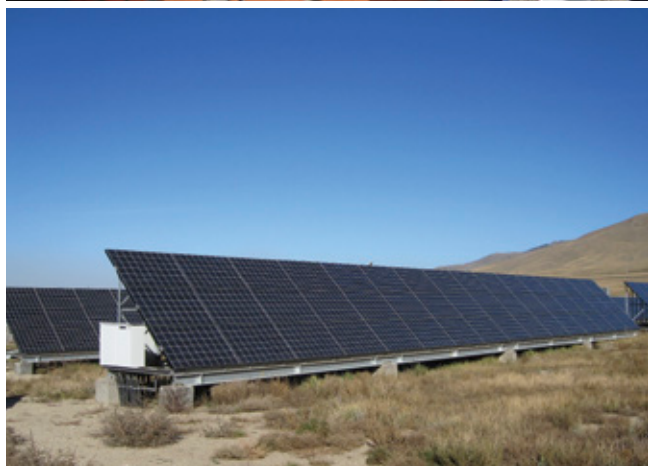
▲photo: ●ミャンマー事業の展望について語る川上業務総括部長 上から ●起工式でのレンガ積みセレモニー(マラウイ) ●完成した太陽光発電システム(モンゴル)
