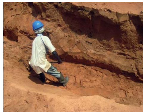
学校建設の工事
