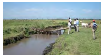
Personnel de JICS réalisant des investigations sur le site prévu pour la construction d'un pont
