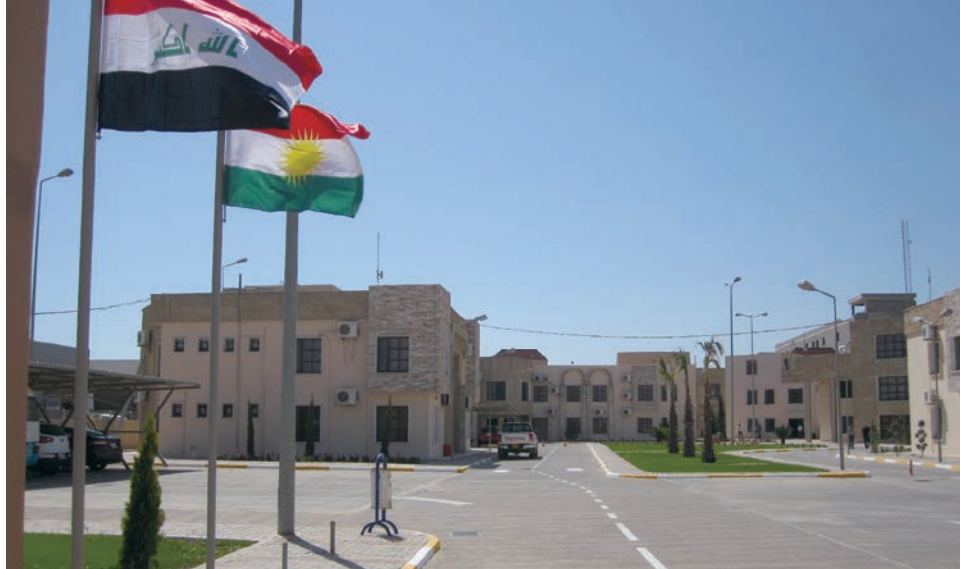
完工したトレーニングセンター ↑
