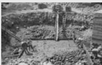
崩壊した橋の修復工事（グアテマラ）
