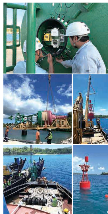
1.メーカーによる調整作業 2.現地作業 3.赤色の灯浮標設置作業 4.現地作業 5.設置された赤色の灯浮標
