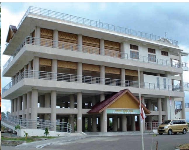
スマトラ沖大地震復興支援による 避難棟建設(2009年インドネシア) ↓
