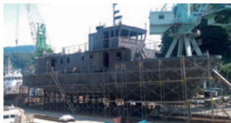
2021年6月、船台(せんだい)上で建造中のマーシャル ↑ 向け医療船(提供：(一財)日本造船技術センター)
