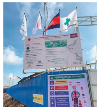
上水場の建設現場
