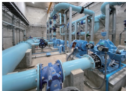
施設内配水管
