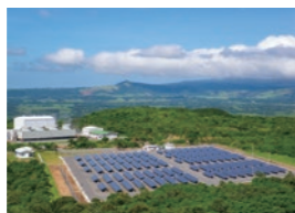
太陽光発電システム
