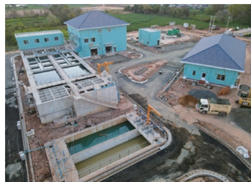
完成した給水施設
