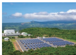
太陽光発電システム
