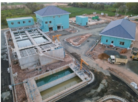
完成した給水施設
