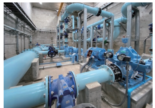
施設内配水管
