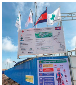
上水場の建設現場
