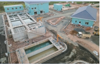
カンボジア コンポントム上下水道拡張計画
