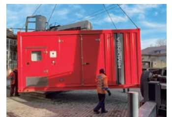
自治体・公共設備：発電機のドニプロ市到着
