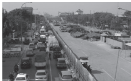
▲ インドネシアにおける監査対象プロジェクトの道路建設現場
