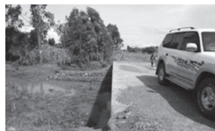
▲ 本案件で建設されたカルバート
