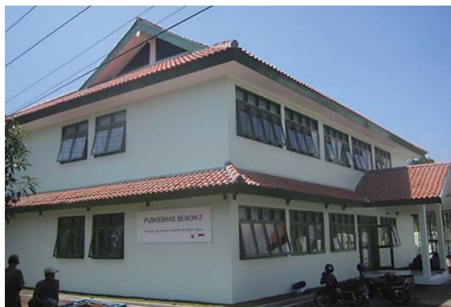
再建されたセウォン第2保健センター
