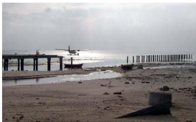
土台等が流されてしまった栈橋（モルディブ）
