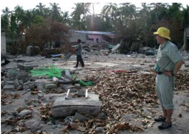
貯水タンク設置所の被害状況を調査するJICS職員（モルディブ）
